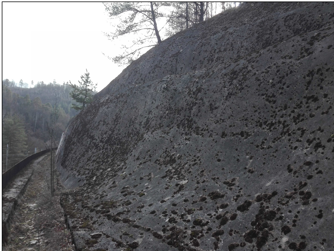
Foto č. 40 km 168,920-169,030 Skalní svah nad zárubní zdí zakrytý betonovým torkretem pohled směr Brno
