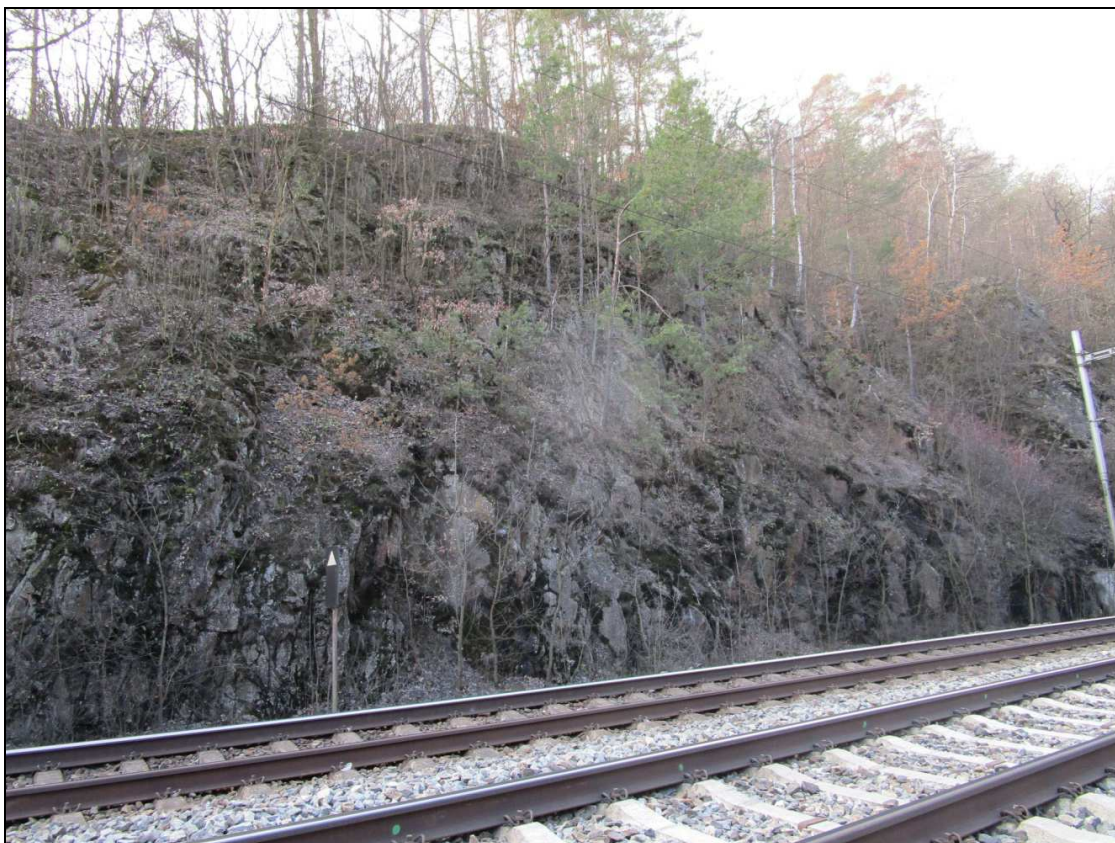
Foto č. 28 Čelní pohled na první stěnu odřezu v 2. části úseku, skalní svah je zde poměrně hustě zarostlý náletovými dřevinami
