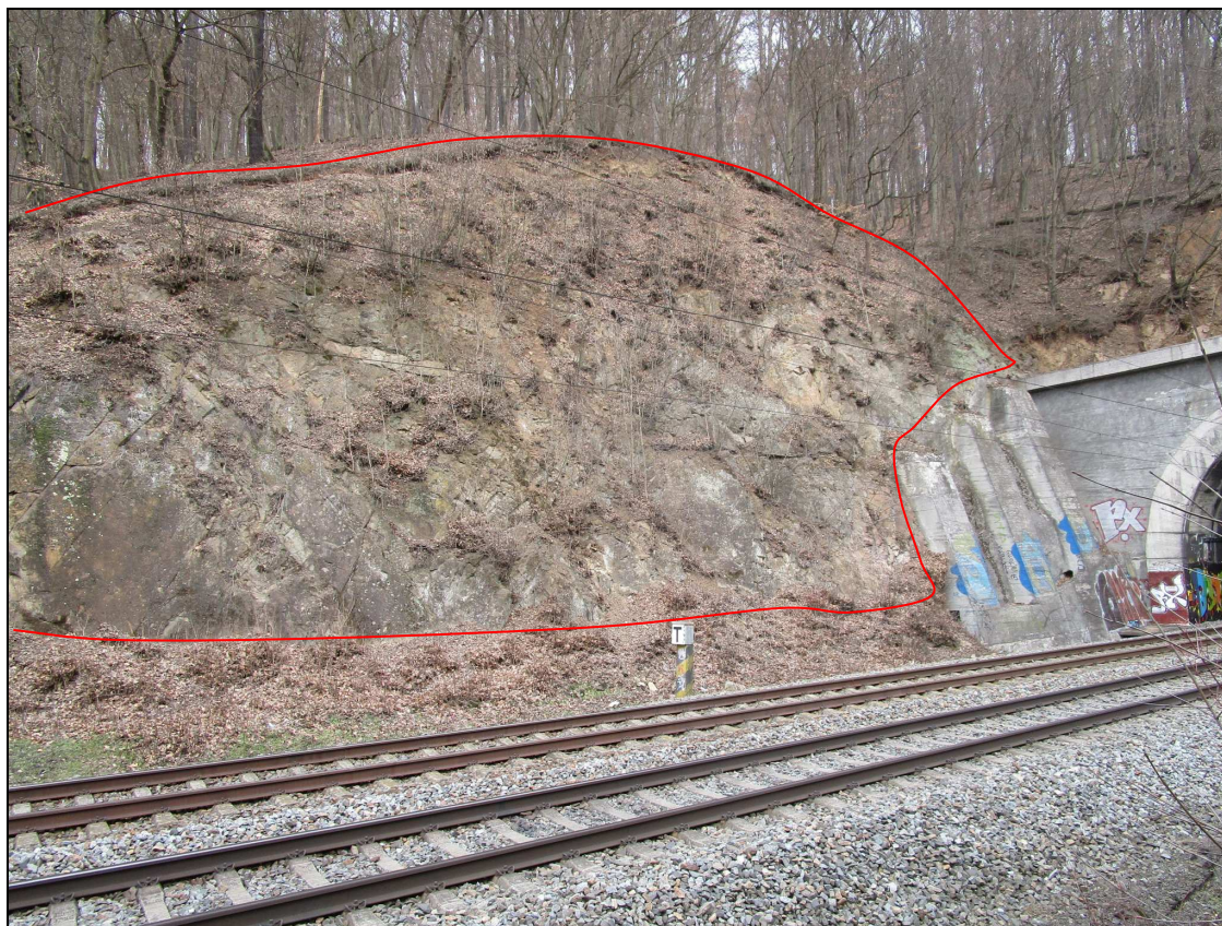
Foto č. 36 Skalní stěna v předportálové části u vjezdového portálu tunelu č. 3, pohled směr Blansko. Červenou čarou je znázorněn rozsah navrženého zakrytí ocelovou ochrannou sítí.
