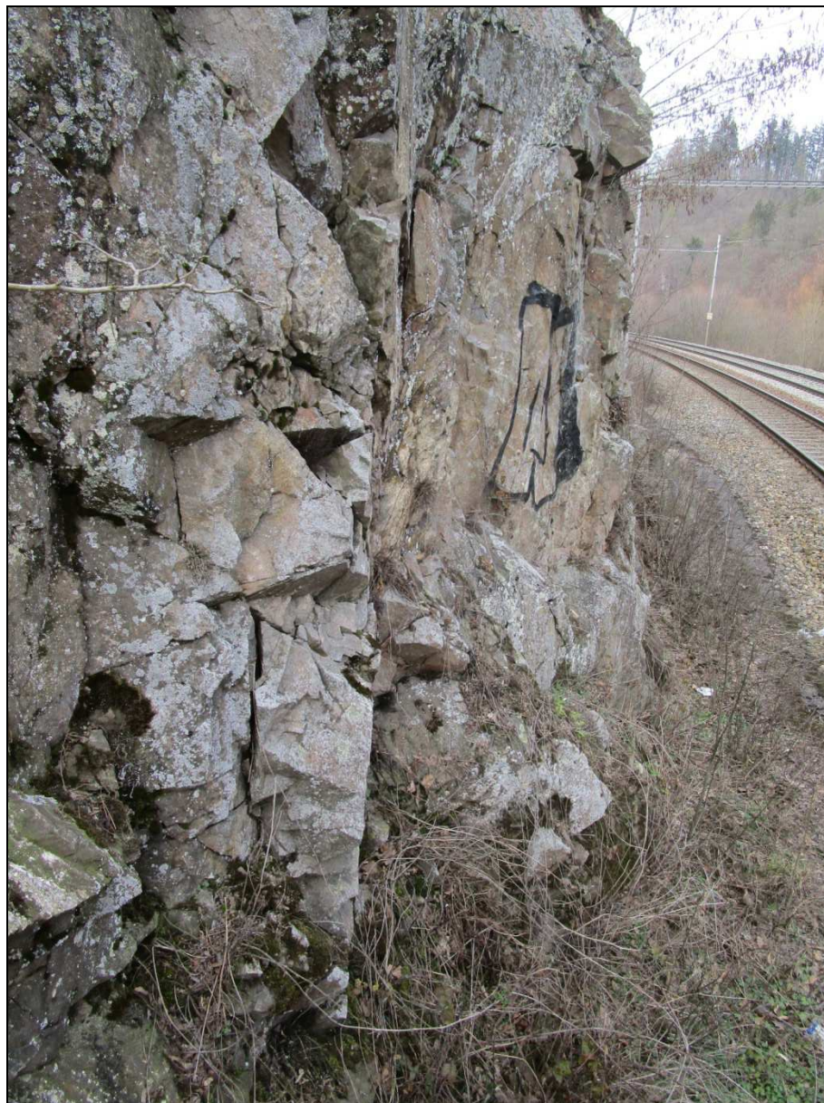
Foto č. 22 km 166,355 Pata skalní stěny odřezu, s patrnými kolmými až mírně převislými puklinami a puklinami ukloněnými ze stěny
