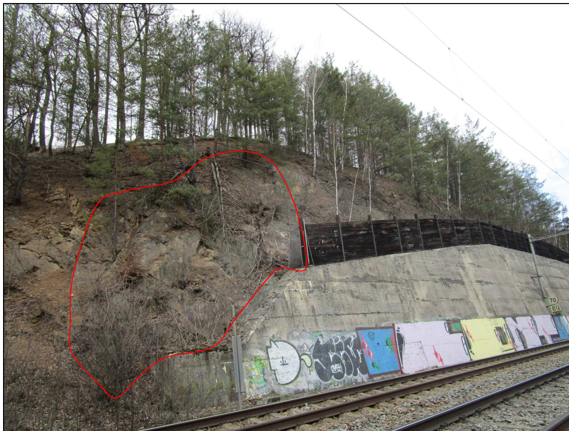
Foto č. 34 Km 167,100-167,140 Betonová zárubní zeď, v koruně se záchytnou bariérou, pohled směr Blansko. Červenou čarou je označen skalní svah určený k zakrytí ochrannou ocelovou sítí
