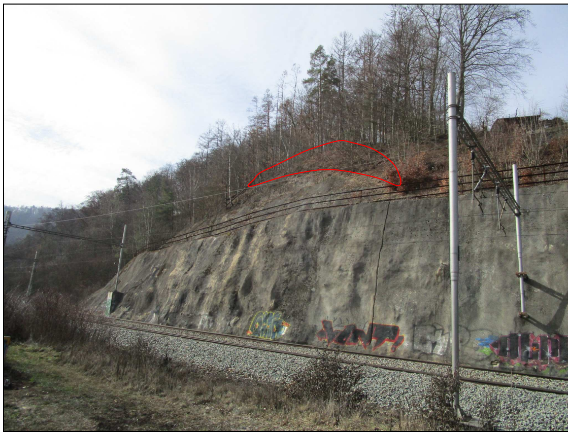
Foto č. 41 Km 170,240-170,290 Zárubní zeď – betonový torkret, pohled směr Brno. Červenou čarou je označeno místo navržené k sanaci.
