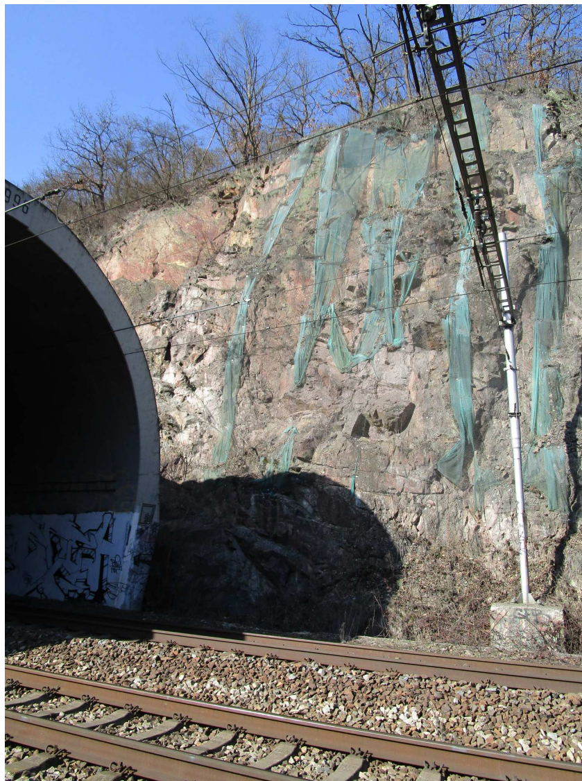
Foto č. 3 Skalní stěna odřezu u výjezdového portálu tunelu č. 1 se zbytky provizorních ochranných sítí. Skalní stěna vlevo při horní hraně je výrazněji zvětralá než stěna vpravo.
