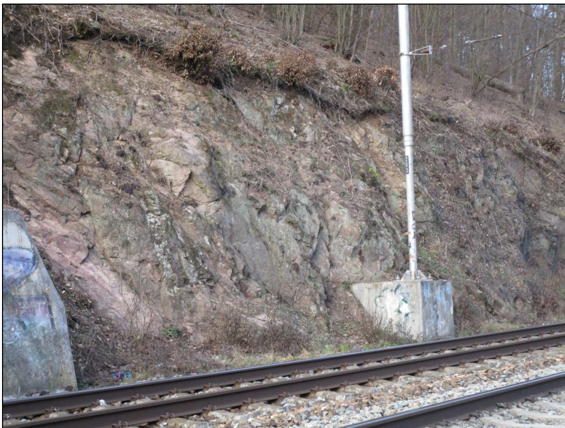
Foto č. 15 Skalní stěna v km 165,805-165,825, vpravo od sloupu je skalní stěna již zakryta ochrannou sítí, pohled směr Blansko
