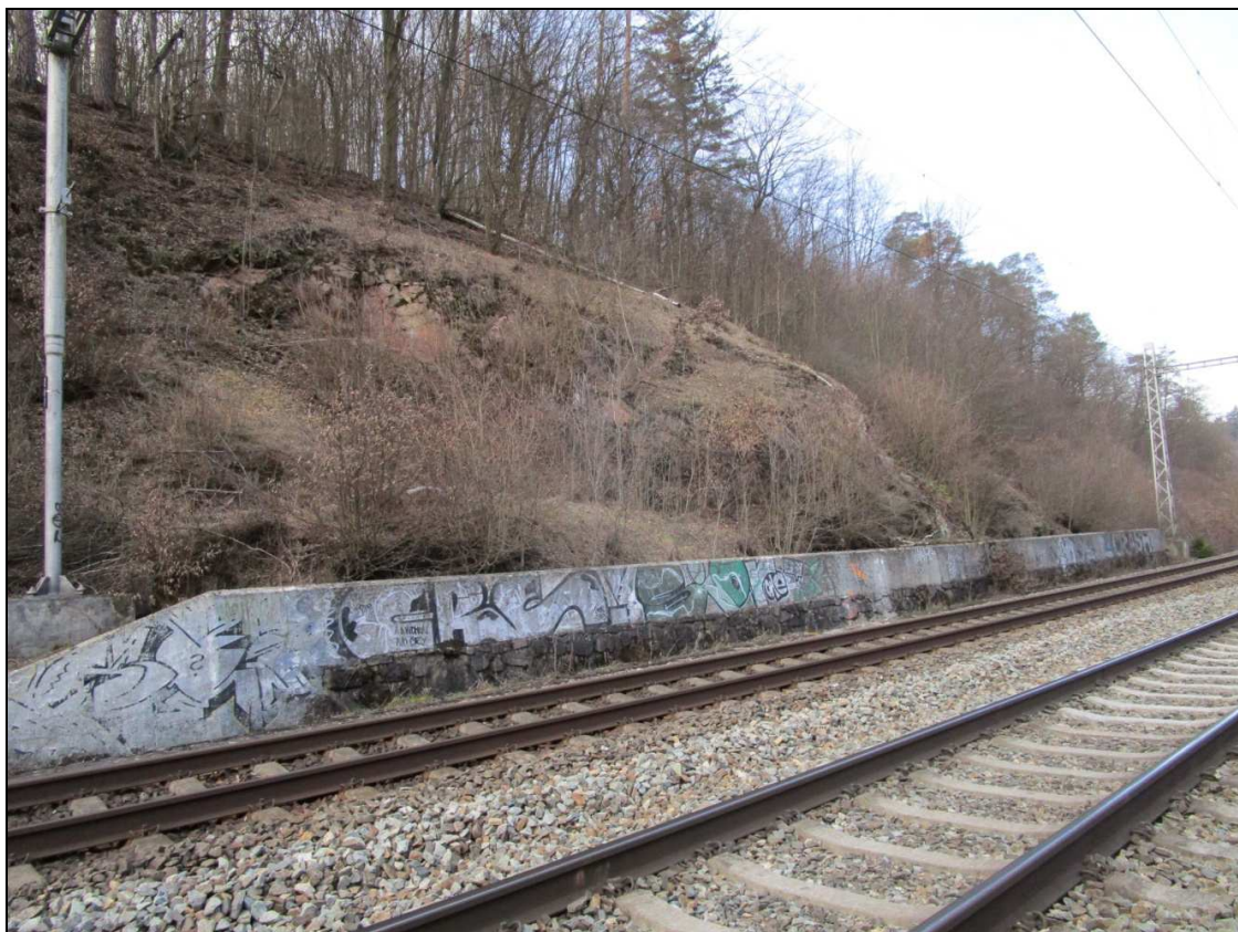
Foto č. 17 Km 165,910-165,950 skalní svah u paty s betonovou zárubní (záchytnou) zdí
