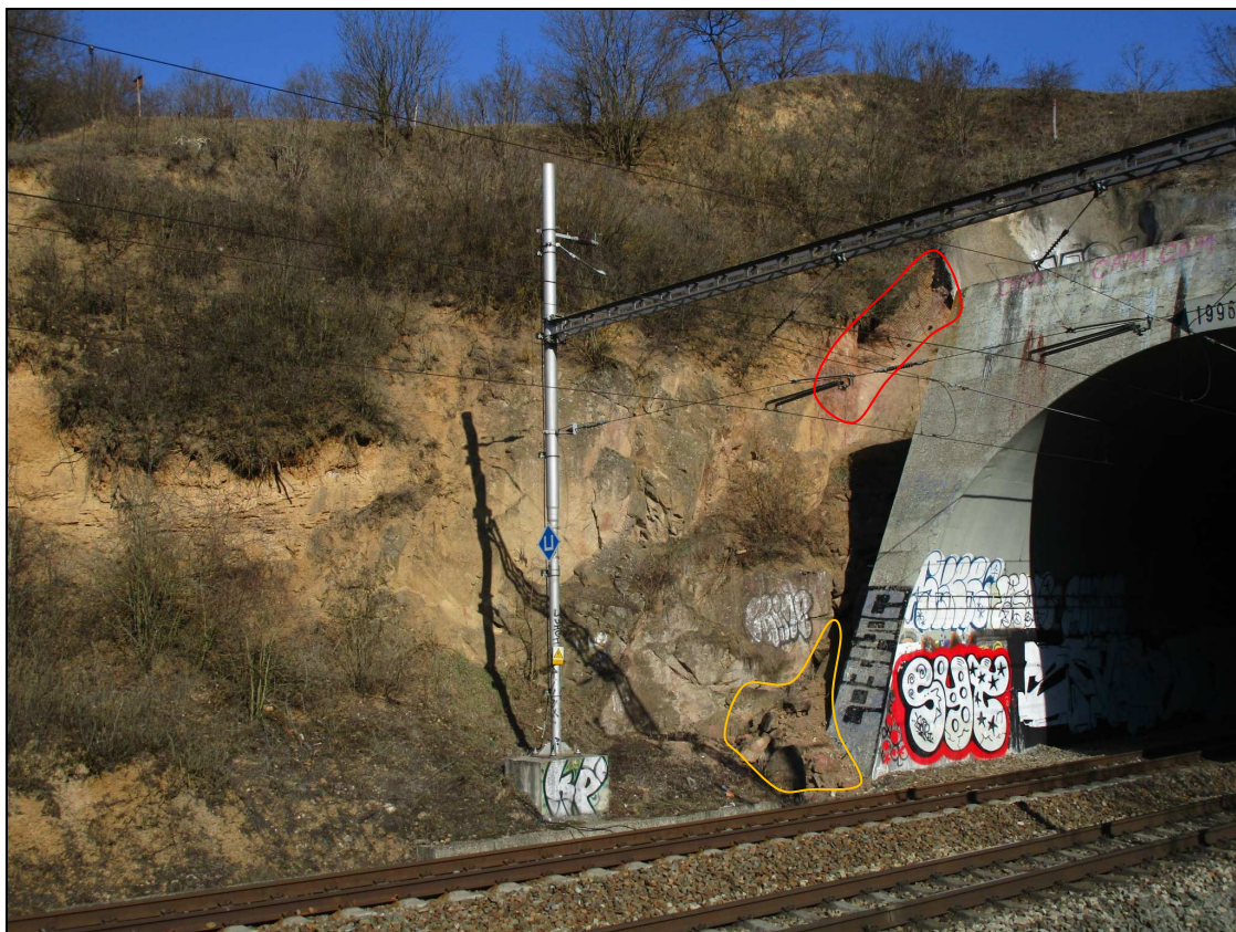
Foto č. 1 km 161,900-161,920 skalní stěna odřezu u vjezdového portálu tunelu č. 1, červenou čarou je označeno místo odkud došlo k pádu horninového bloku, oranžovou čarou jsou označeny zřícené bloky u paty stěny
