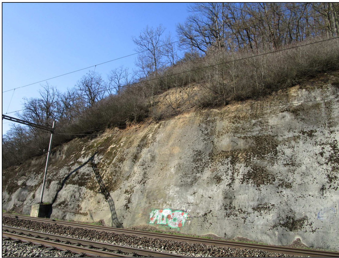
Foto č. 32 Km 162,800-162,860 Skalní stěna odřezu zakrytá torkretem, pohled směr Brno. Ve svahu nad torkretem poloha zvětralin bez vegetačního pokryvu.
