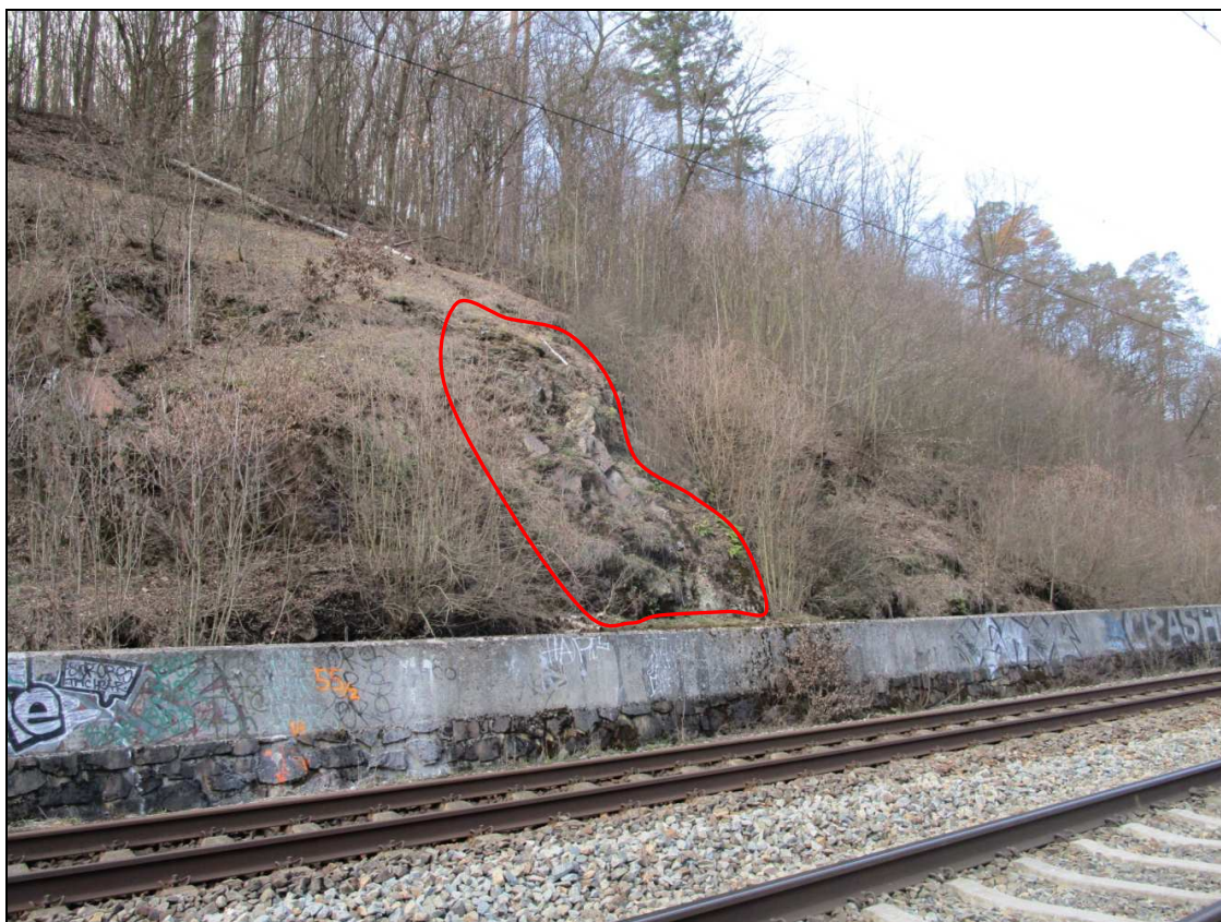
Foto č. 18 Skalní stěna v km 165,930, červenou čarou je vyznačena část, kterou bude vhodné zakrýt ochrannou sítí
