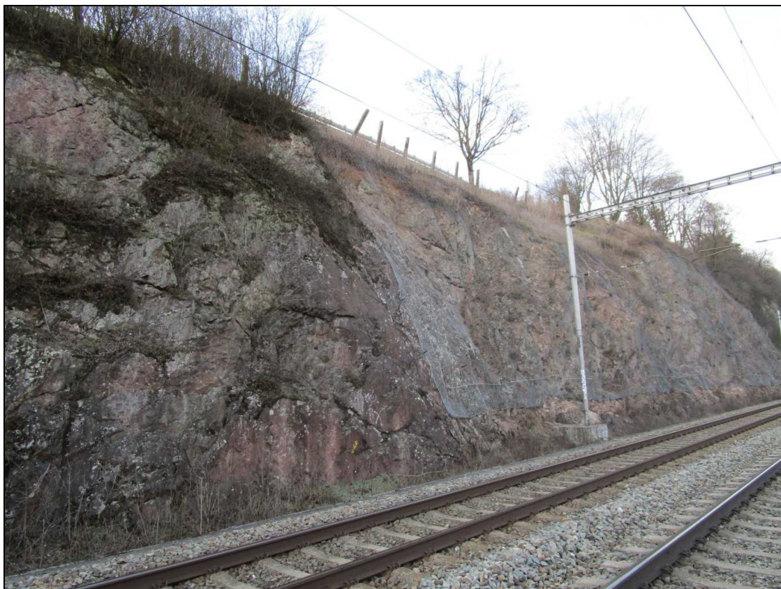
Foto č. 13 Km 165,150-165,240, skalní stěna zakrytá ochranou ocelovou sítí, pohled směr Blansko
