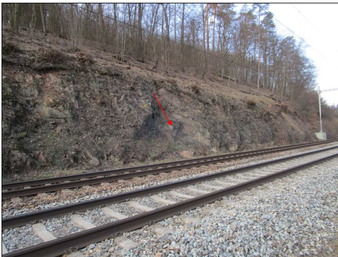
Foto č. 16 Km 165,810 - 165,865, skalní stěna odřezu o výšce 4-6 m, zakrytá ochrannou ocelovou sítí, šipkou je označena skalní plotna
