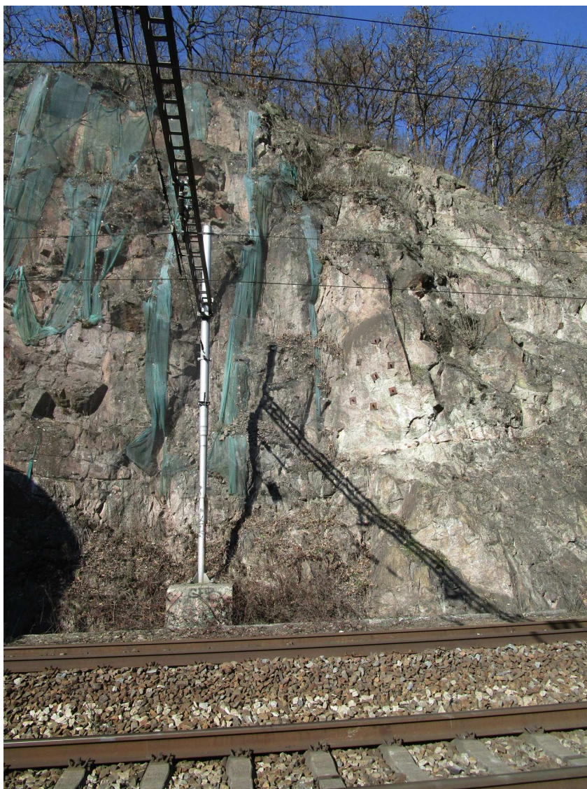
Foto č. 4 Skalní stěna odřezu u výjezdového portálu tunelu č. 1 se zbytky provizorních ochranných sítí a tyčovými kotvami.
