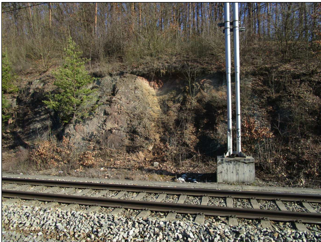
Foto č. 7 km 163,250 skalní stěna odřezu o výšce cca 3 m, červenou čarou je označena zvětralá poloha, odkud došlo k opadávání fragmentů horniny.
