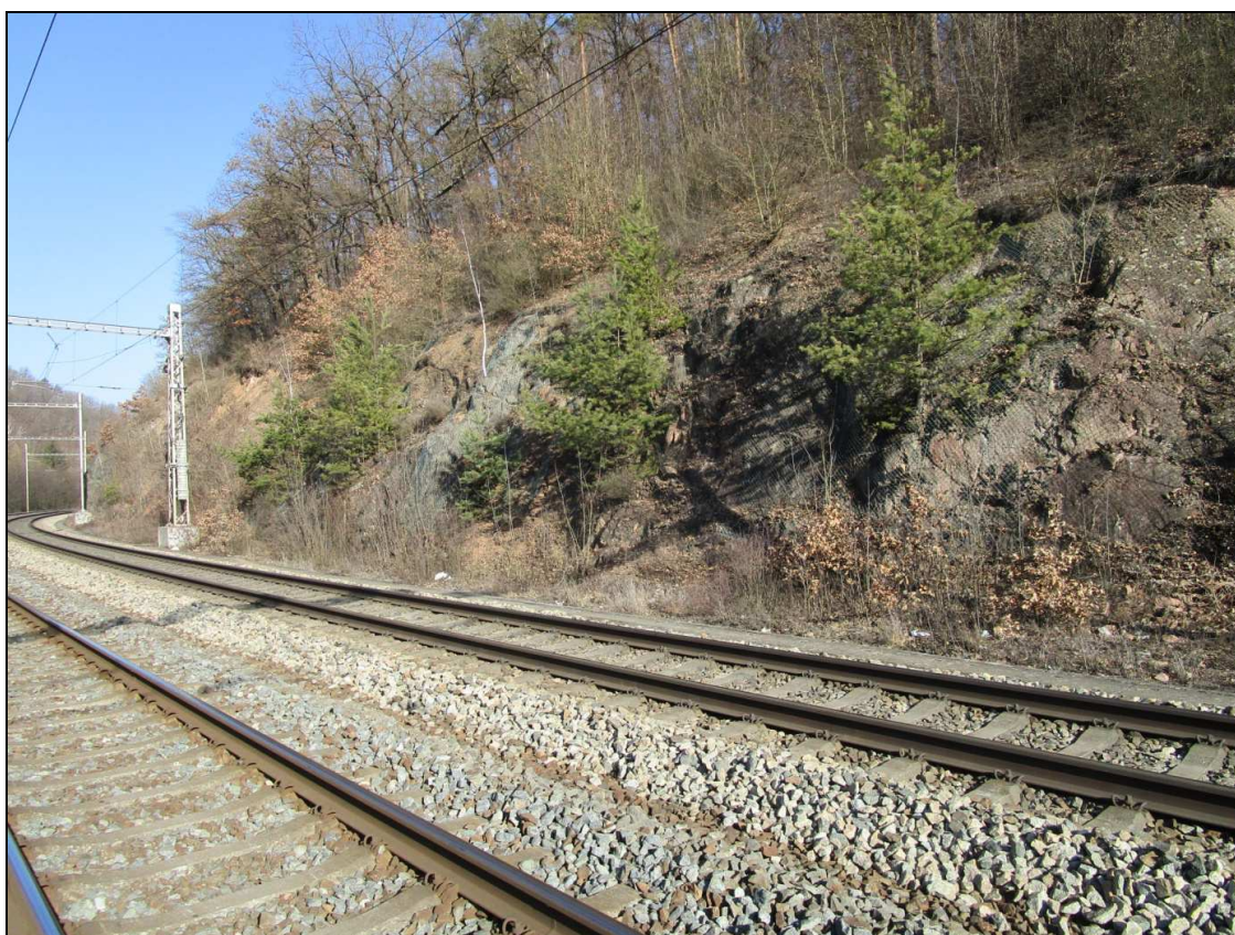
Foto č. 8 km 163,255-163,295 skalní stěna odřezu o výšce cca 4-5 m, stěna je zčásti zakrytá ochrannou sítí, pohled směr Blansko
