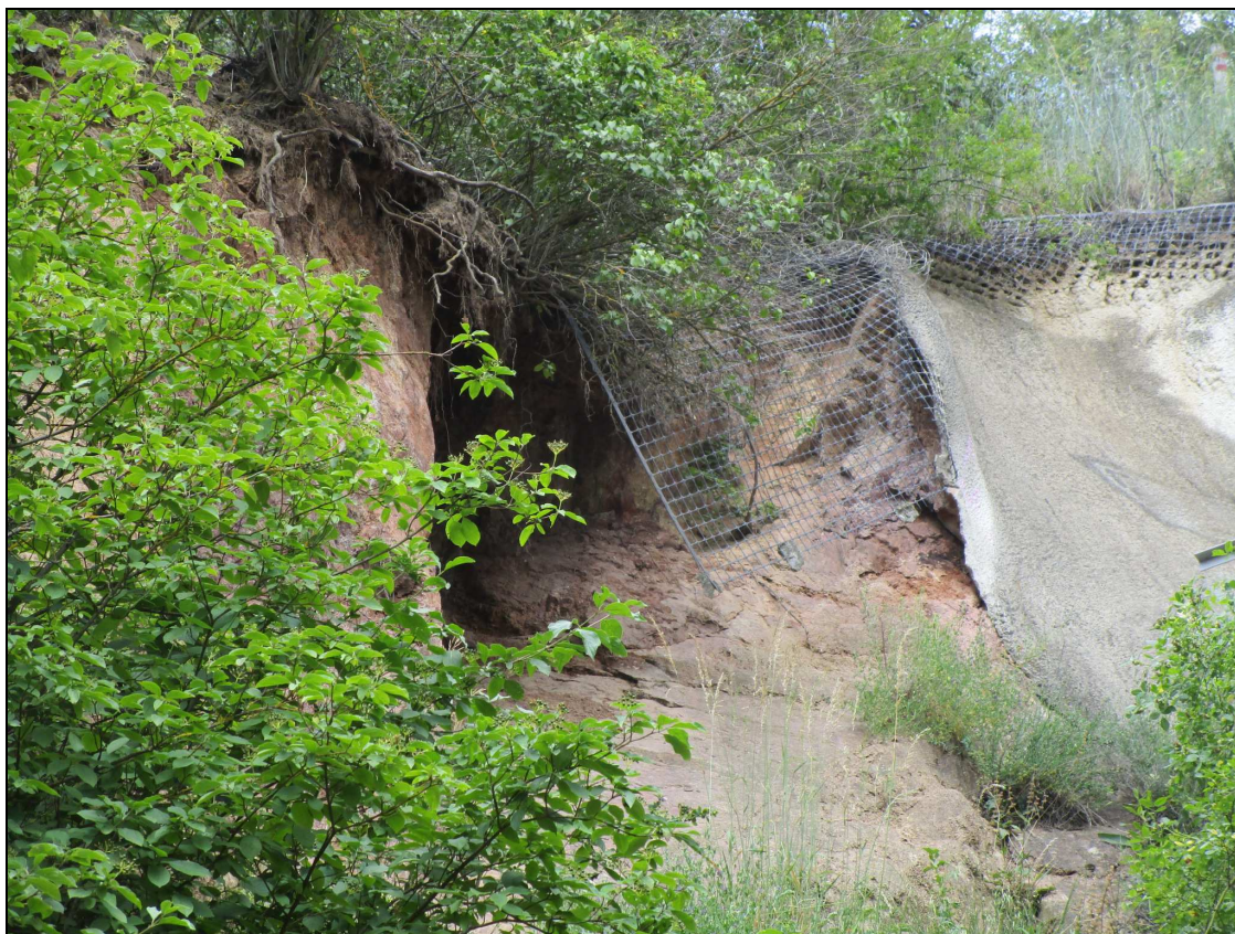
Foto č. 2 Detail místa odloučeného skalního bloku při horní hraně se zbytky torkretu a geosyntetické sítě, patrné je silné zvětrání horniny podél puklin
